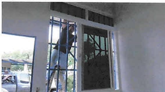
Foto1: Instalación de ventanas
