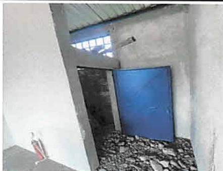
Foto 5: Remozamiento de sanitarios
