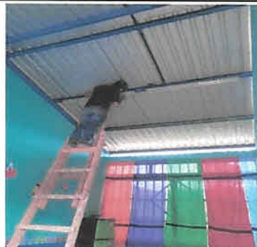
Foto 4: Colocación de lamparas
