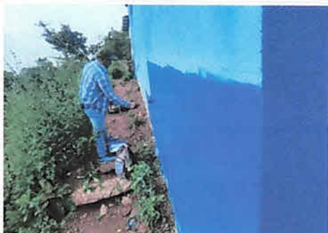
Foto 3: Pintado de instalaciones parte exterior
